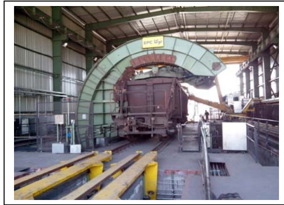
SISTEMA AUTOMATICO RIBALTA VAGONI CAR DUMPER
