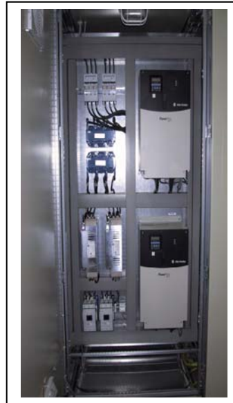
QUADRO INVERTER GESTIONE VELOCITA' TRASPORTI
