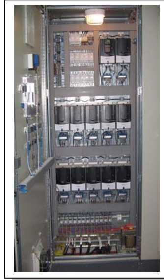
QUADRO INVERTER REGOLAZIONE VELOCITA' RULLIERE
